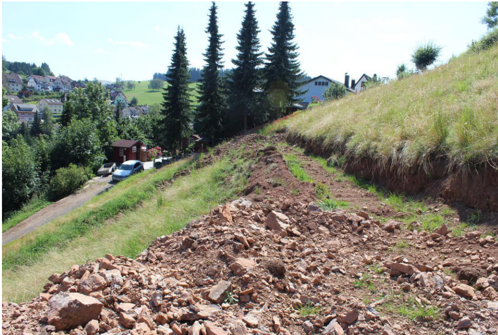
Abb. 11: Blick nach Süden auf Flurstück 14/7 mit der beschriebenen Baggertrasse
